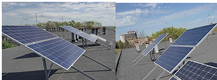
Фиг. 1. Снимки на четири СП монтирани стационарно на покрива на лабораторията от Университета в южна посока с ъгъл на наклон до 45^0 .
